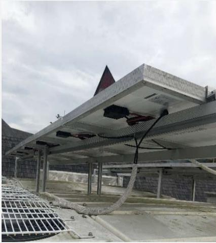
Instalasi panel surya di atas geladak teratas (compass deck) dengan posisi kabel yang menggantung
