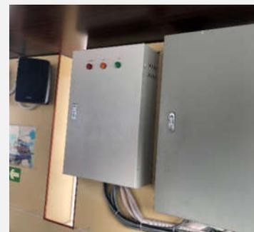
Instalasi panel kontrol dan panel hubung bagi generator panel surya dengan generator utama
